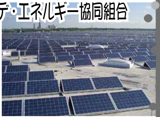
流通センターの屋根に5万平米、1,9MWのソーラーパネル (写真提供: レアテ電力公社)
