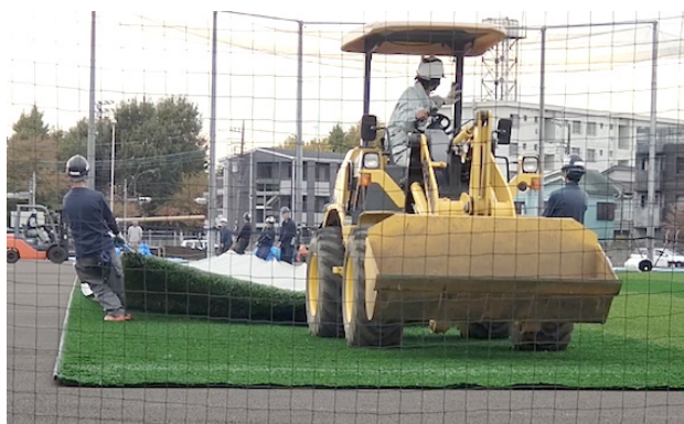
人工芝の敷設光景
