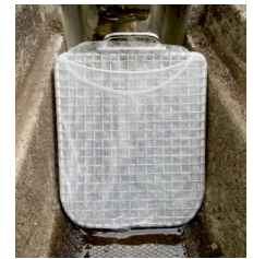
排水溝に設置した不織布を張ったフィルター
