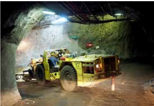
工事が進むコンラード最終処分場
