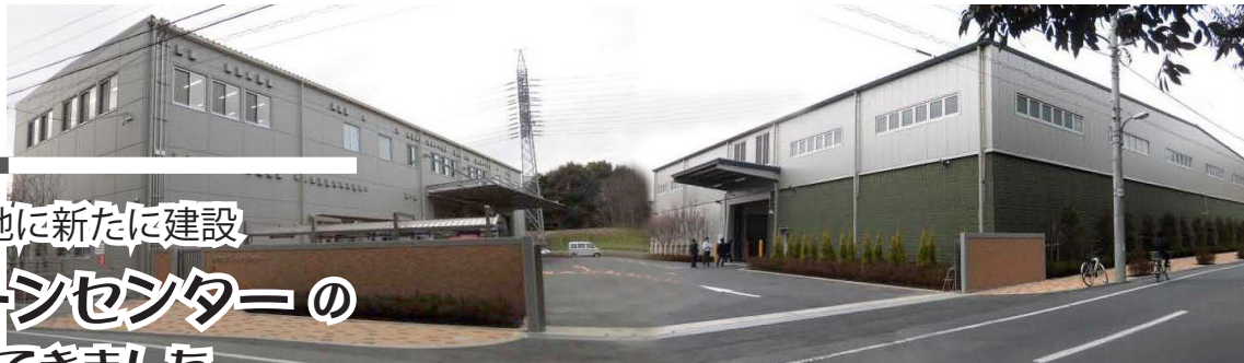
正面入り口から、左管理棟、右作業棟（黒っぽい部分は二重壁）
