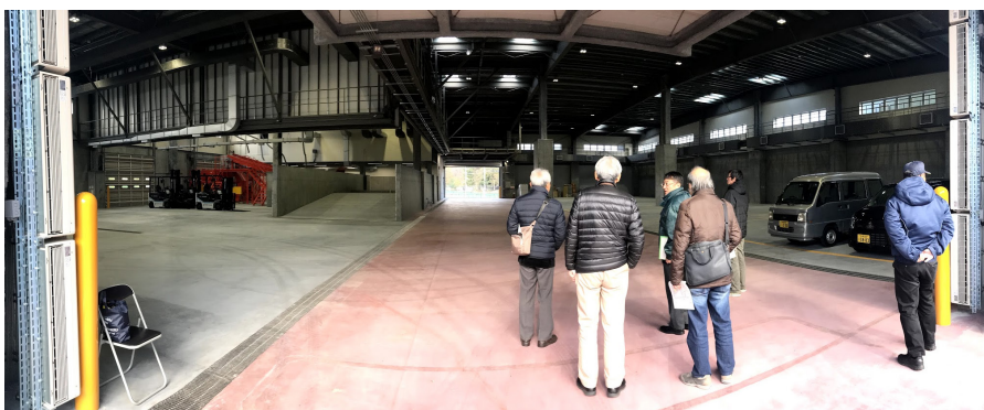
作業棟。右側は古紙・古布ストックヤード。防音のため壁は二重になっていて、内壁には防音材が使用されている。車両は東八道路にたまるのを避けるため、敷地内を一周するように走り、奥の入り口から入場する。
