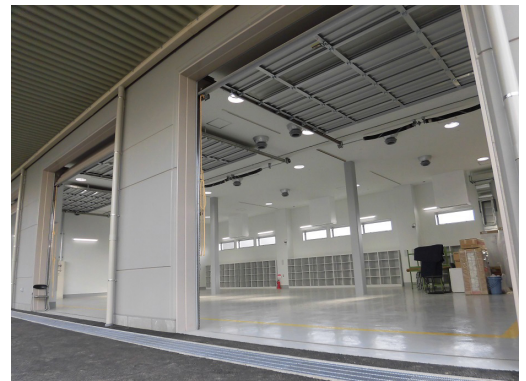
管理棟1階。粗大ごみストックヤード。
